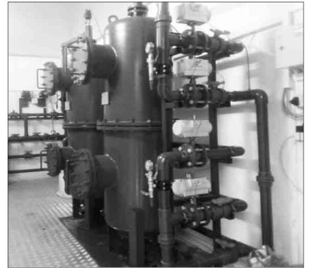
Во второй декаде ноября в с. Дудоровский привезено и установлено оборудование для очистки воды от примесей железа. Здесь запущена и работает станция обезжелезивания питьевой воды.
